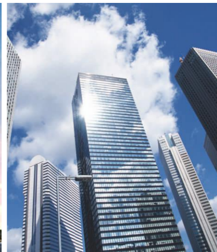
太原国丰大厦 Guofeng building 27层/站 3.0m/s
